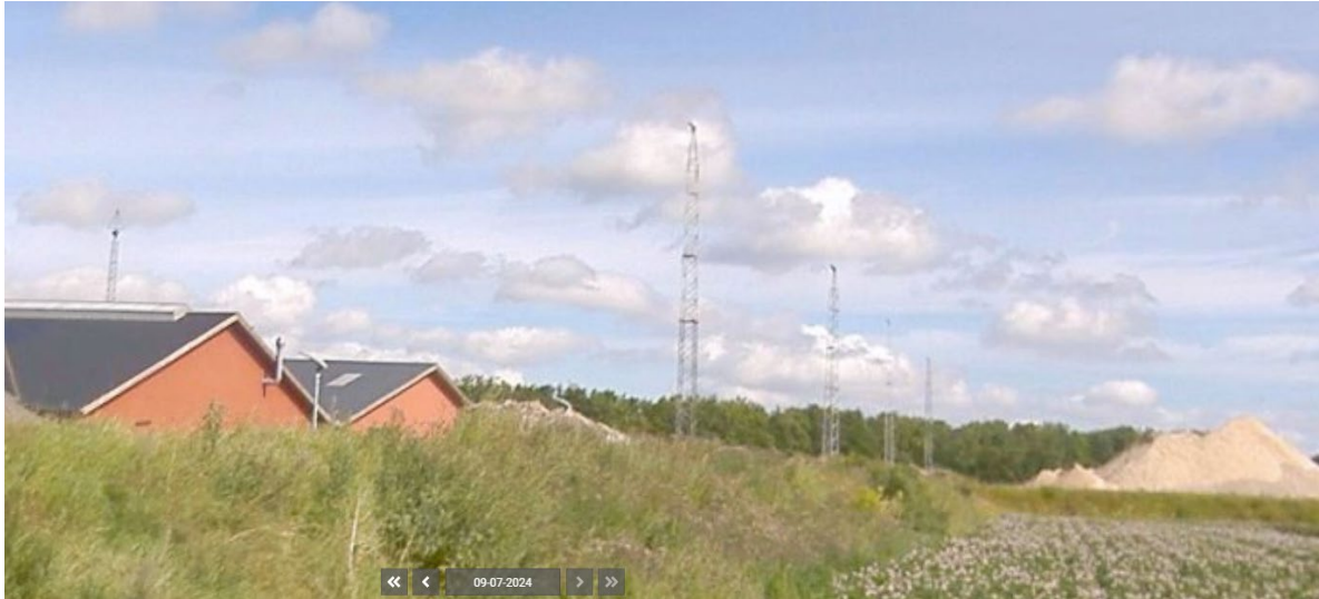
Foto der viser de 5 lysmaster som lovliggøres ved nærværende landzonetilladelse.
